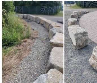
Zustand bei Flächenbegehung am 10.07.2023
